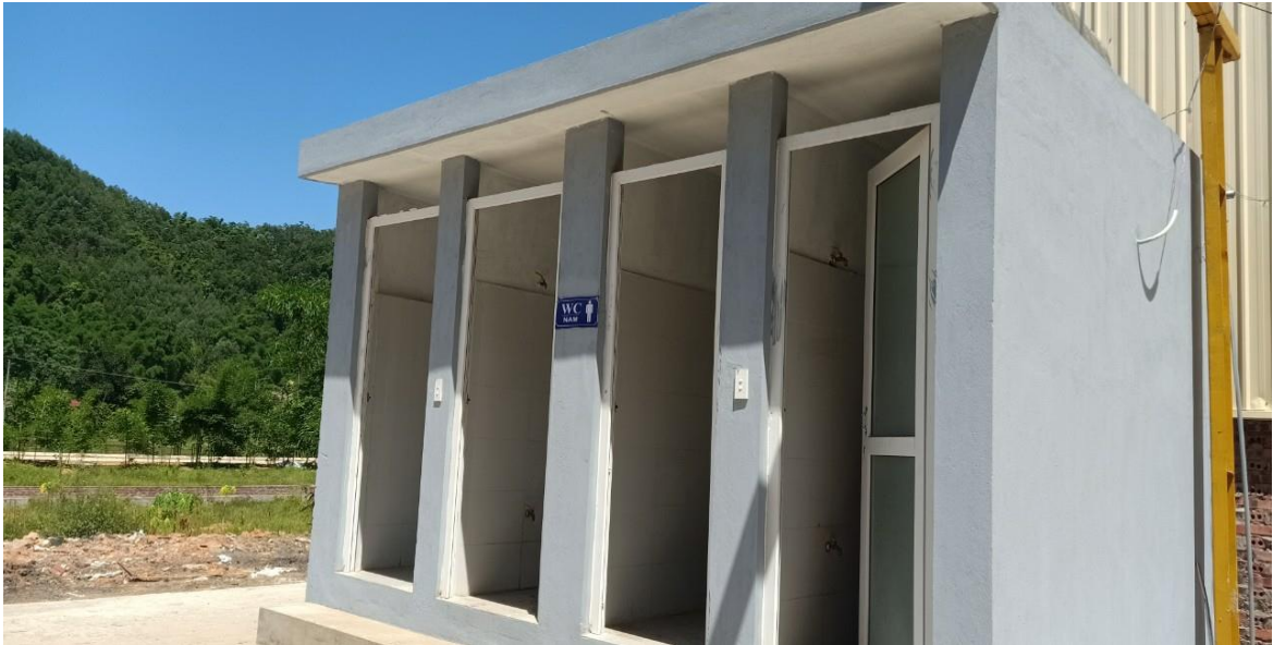
Hình 3. 4. Hệ thống xử lý nước thải tập trung đã xây dựng của dự án đầu tư
